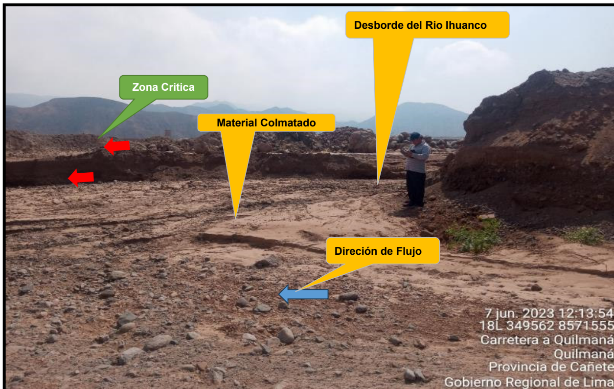
FIGURA N°05: SE MUESTRA LA SOCAVACION Y EL DESBORDE QUE PRODUCE EL RIO IHUANCO EN AVENIDAS DE HUAYCO
